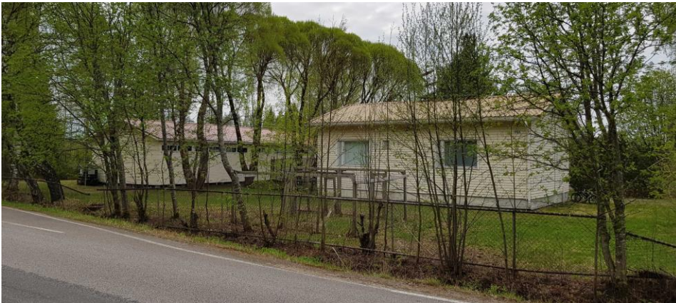
Kuva 70. Asuinrakennus ja talousrakennus (Jylhämäntie 662).
