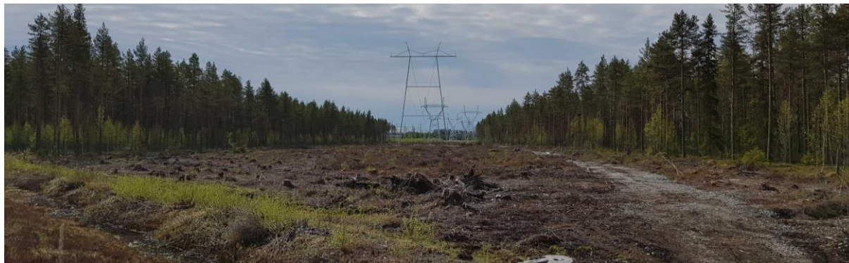
Kuva 28. Rakenteilla oleva voimalinja Nuojuankankaan sähköasemalta pohjoiseen. Näkymä Jylhämäntieltä pohjoisen suuntaan.
