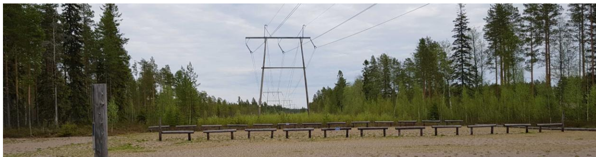
Kuva 29. Oulujoen pohjoispuolella Nuojuasta koilliseen johtava voimalinja kulkee Lamminahon tilan pysäköintialueen ylitse.
