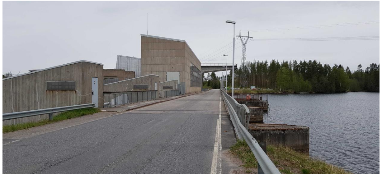
Kuva 35. Nuojuan voimalaitos, näkymä patosillalta luoteeseen.
