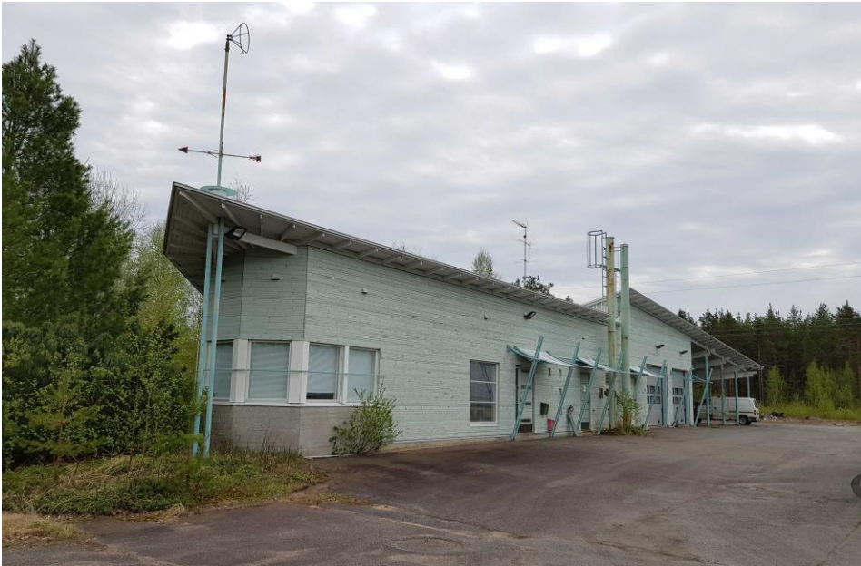
Kuva 60. Toimistorakennus on ulkoasustaan päätellen rakennettu 1980–1990-lukujen vaihteessa.
