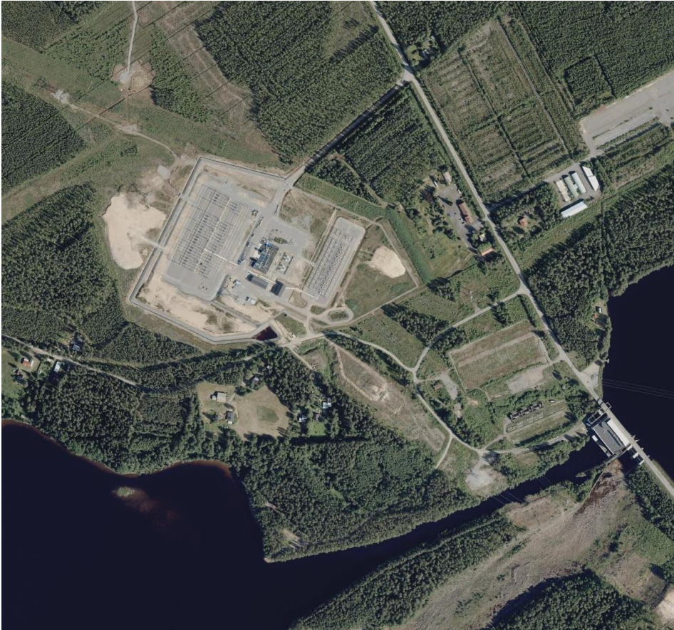
Kuva 73. Nuojuankankaan sähköasema ilmakuvassa, 2025. (Kuva Maanmittauslaitos / Paikkatietokunta).
