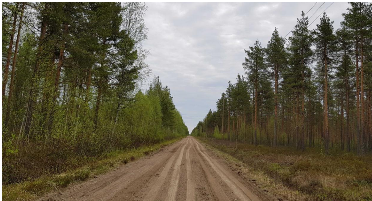
Kuva 26. Lamminahontie. Tien rinnalla kulkee voimalinja.
