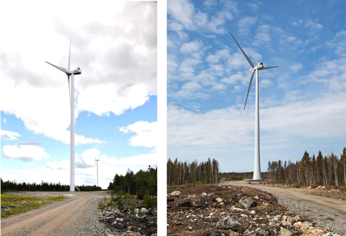
Kuva 11. Vasemmalla on esimerkki teräslieriötornista ja oikealla hybriditornista. (Kuvat: Leila Väyrynen ja Ville Suorsa, FCG)
