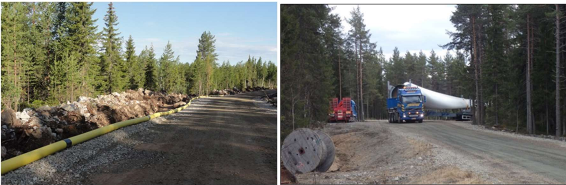
Kuva 17. Vasemmalla kuvassa on esimerkki tuulivoimapuiston rakennus- ja huoltotiestä. Teitä käytetään muun muassa betonin, soran ja voimaloiden komponenttien kuljetuksiin sekä tuulivoimapuiston käyttövaiheessa huoltoajoihin. Maakaapeli sijoitetaan ojakaivantoon tien reuna-alueelle. Oikealla kuvassa tuulivoimalan osia kuljetetaan erikoiskuljetuksina. (Kuvat: Ville Suorsa / FCG).
