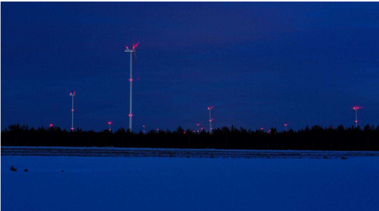
Kuva 13. Kiinteät punaiset lentoestevalot pimeällä. (Kuva: Ville Suorsa/FCG)
