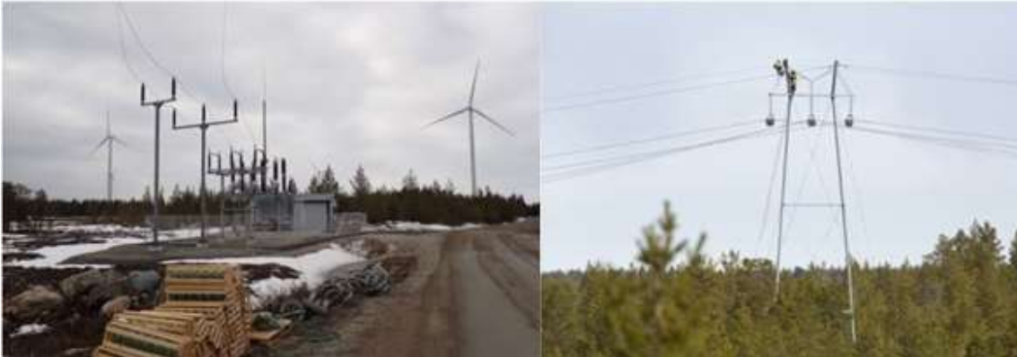
Kuva 19. Sähköaseman ja voimajohdon rakentamista.
