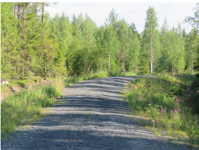
Kuva 17. Tielinjaus kohti vp 50 pohjoiseen.
